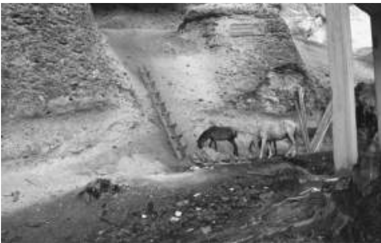
Foto 7. Mirador en construcción abandonado frente a la gruta de El Gigante con acumulación de basura y material de construcción. Foto de Ana Hasemann Lara, 2012.
